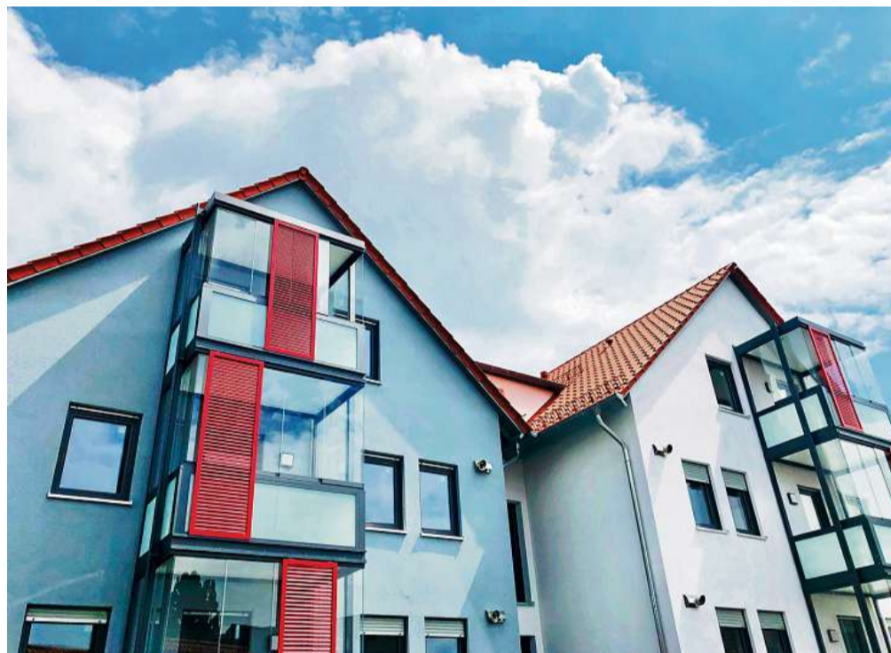
Die zwei Gebäudekomplexe sind miteinander verbunden.
